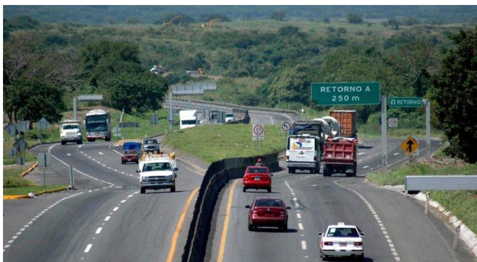
Imagen 7. Obras de mejoramiento en la Carretera Guadalajara-Salttillo
