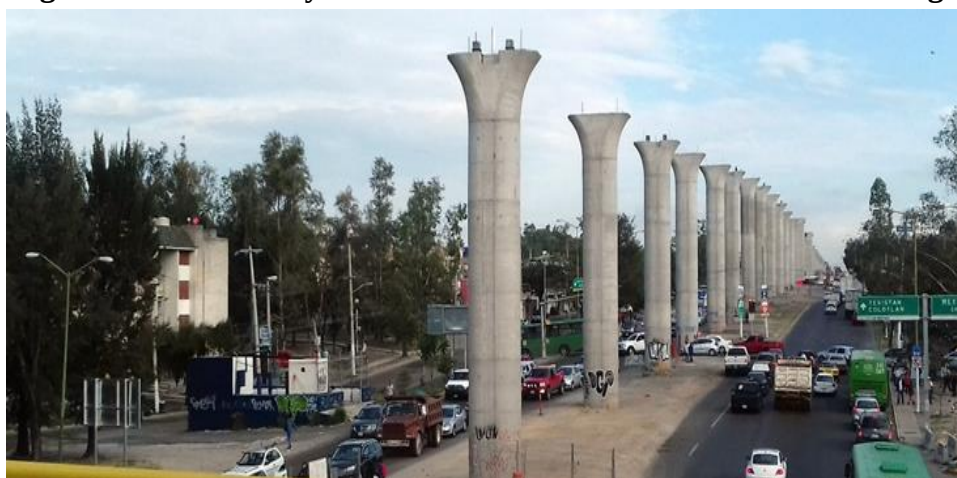
Imagen 5. Av. Tesistán y la construcción de la Línea Tres del Tren Liger
